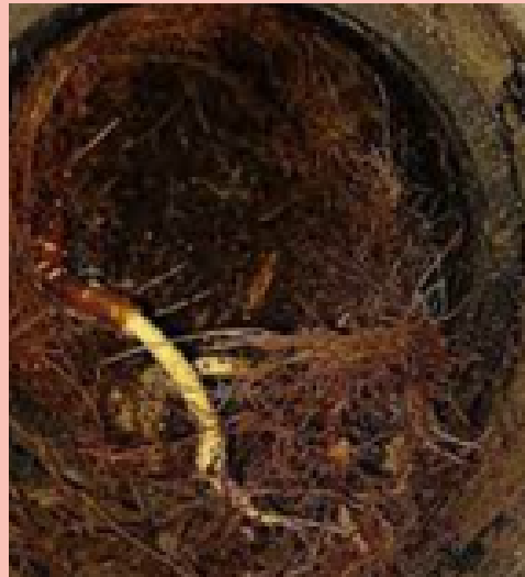
DES RACINES BOUCHENT CERTAINS CONDUITS DES CANALISATIONS D'EAU PLUVIALE AUTOUR DE LA PLACE DE LA HALLE
